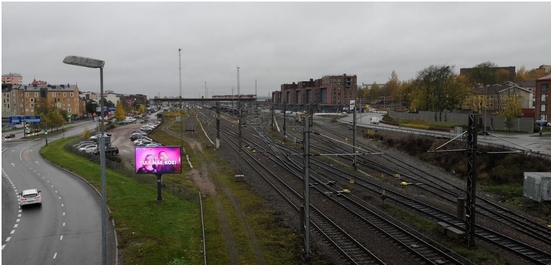
Kuva 28. Turun nykyistä ratapiha-aluetta, johon juna-aseman laiturit tulevaisuudessa siirretään.
